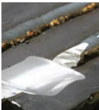
Удаление сварных швов на стали
